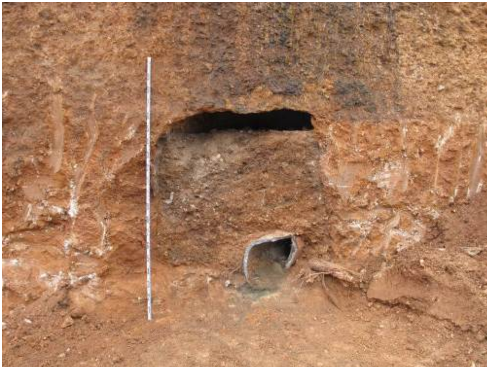
Foto 87: Estat de la mina després de la demolició del mur UE 11
