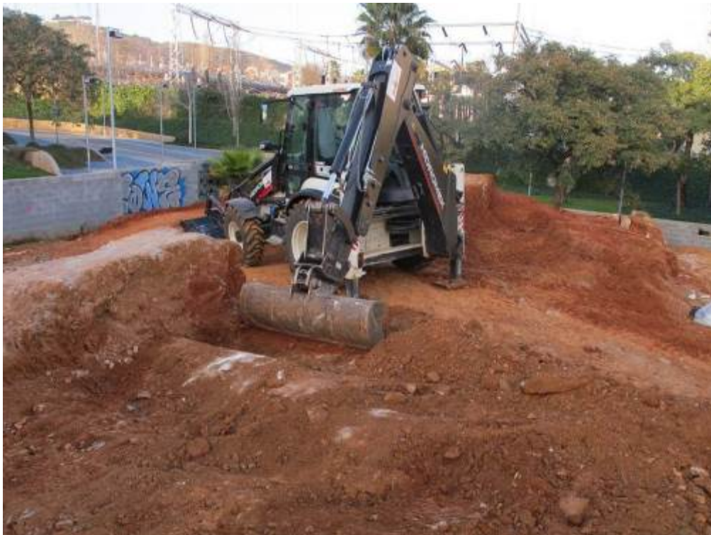
Foto 12: Tasques de delimitació d'estructures
