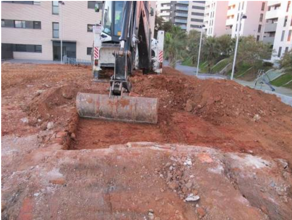
Foto 9: Meitat S. Tasques de delimitació d'estructures
