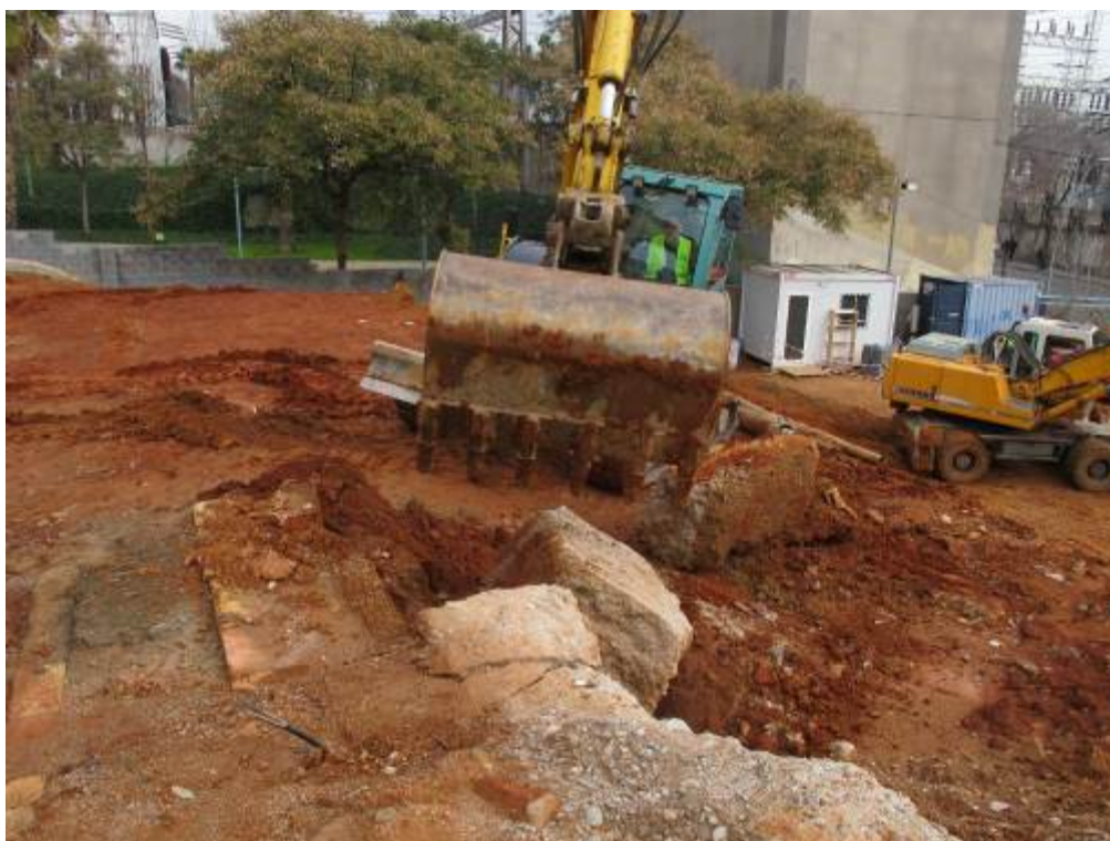
Foto 125: Tasques d'eliminació d'estructures amb supervisió. UE 14, UE 22
