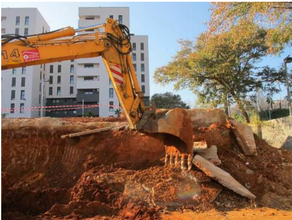
Foto 123: Tasques d'eliminació d'estructures. UE 11 i paviment UE 32
