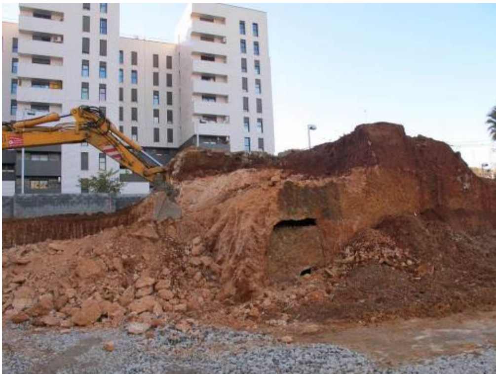
Foto 91: Tasques d'excavació al voltant de la mina
