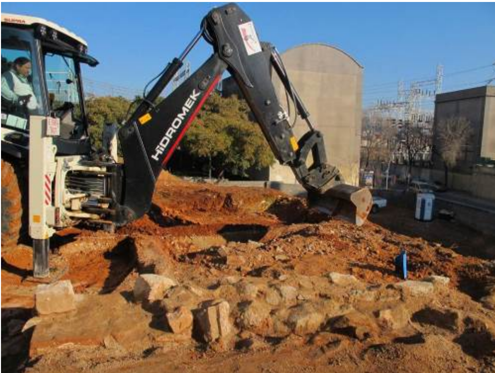
Foto 8: Tasques de delimitació d'estructures
