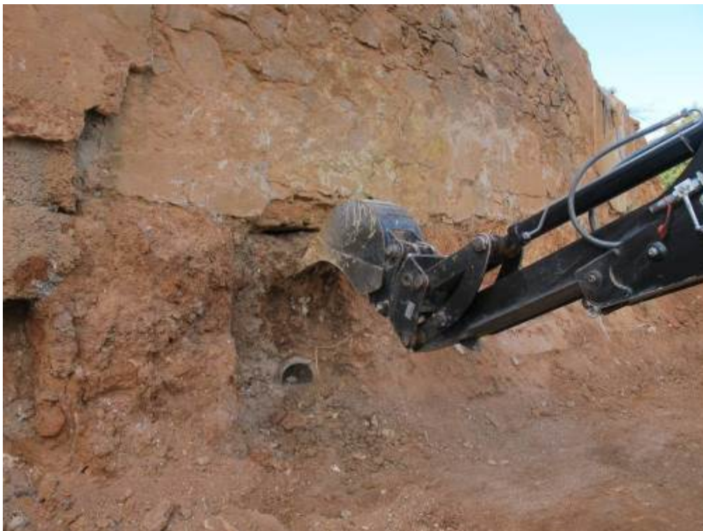
Foto 79: Mina. Tasques d'excavació mecànica
