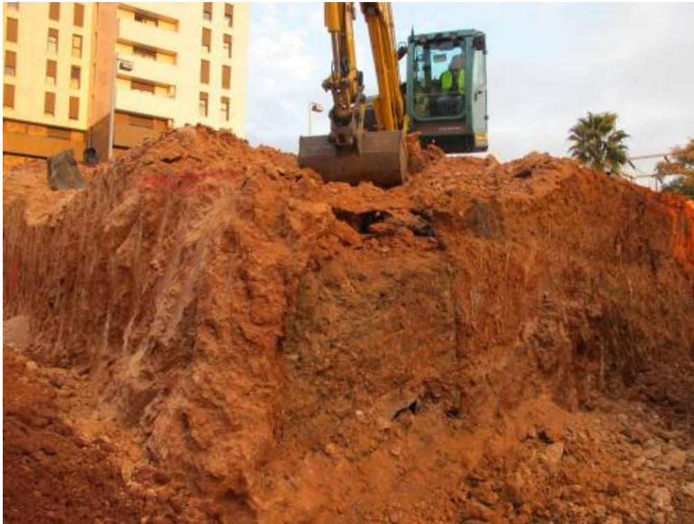
Foto 94: Mina. Tasques d'excavació per la part superior
