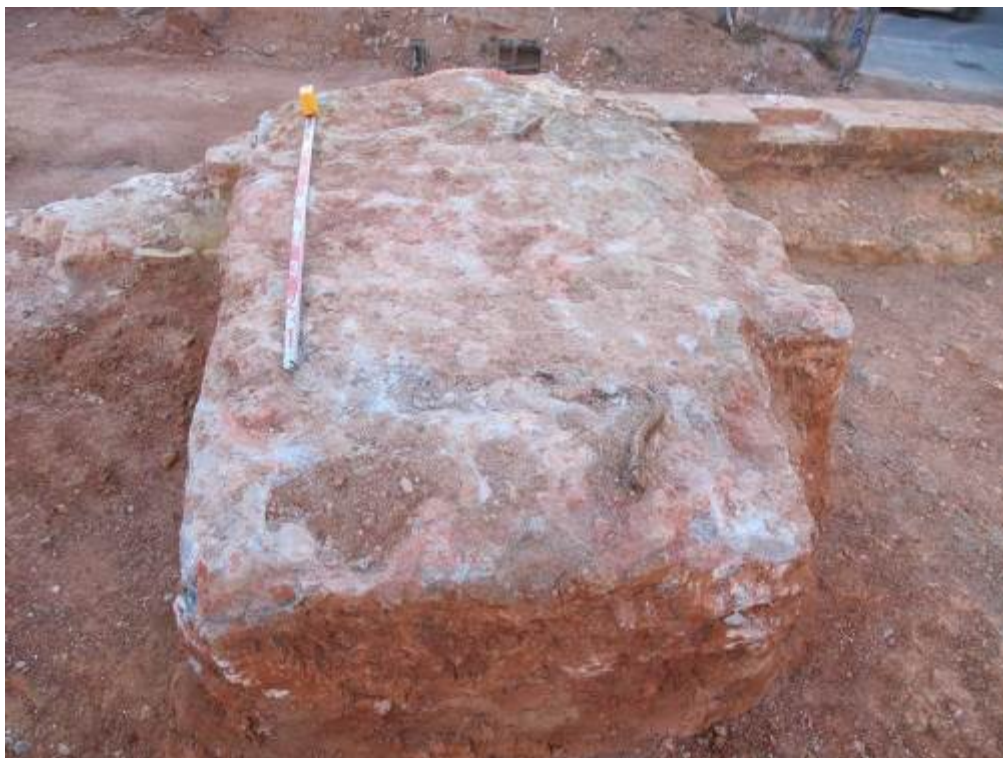
Foto 51: Fonamentació de pilar UE 16
