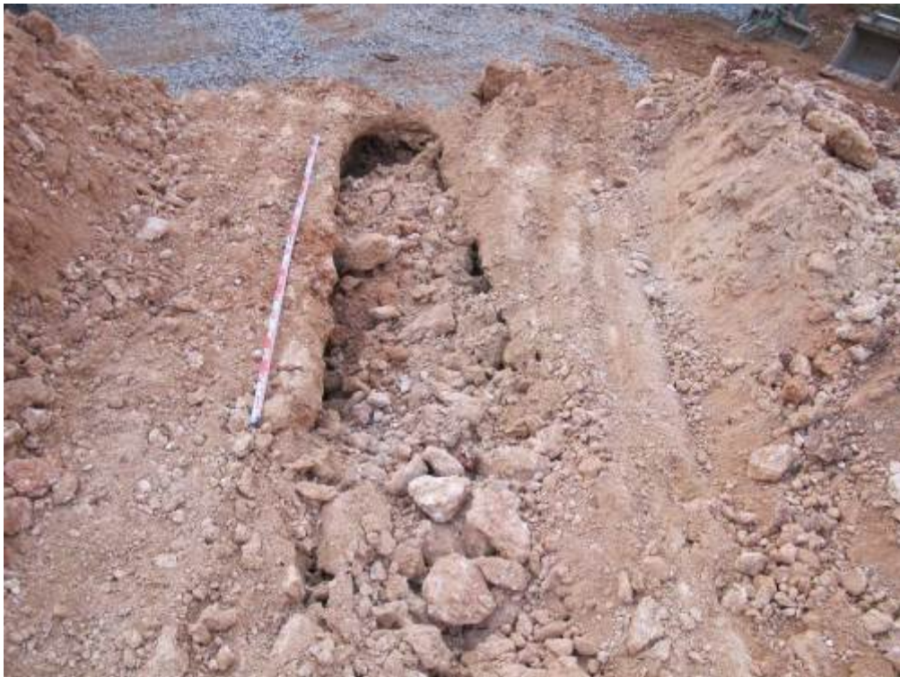
Foto 95: Mina. Tasques d'excavació per la part superior
