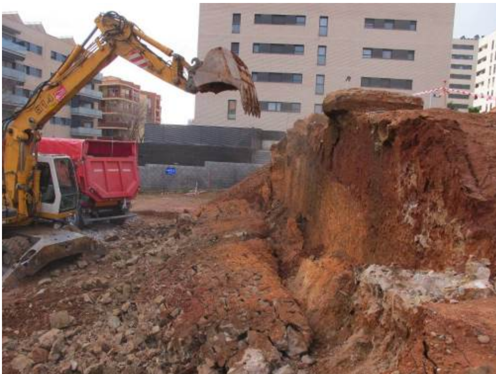
Foto 119: Tasques d'eliminació d'estructures amb supervisió. UE 11
