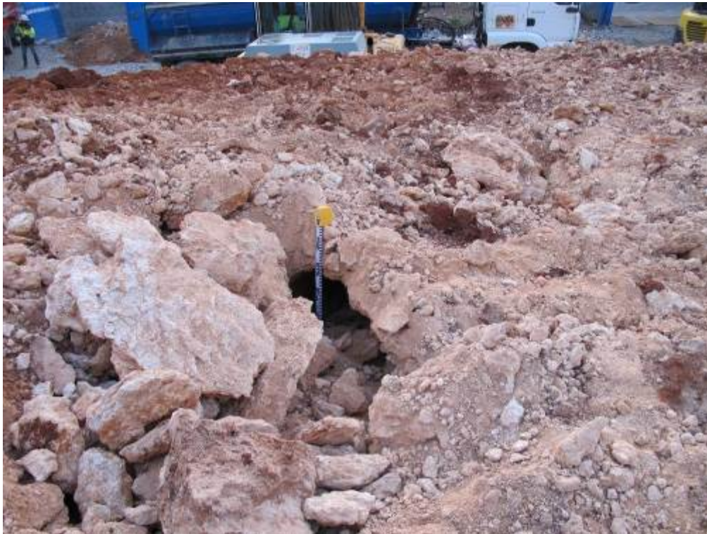
Foto 92: Mina. Tasques d'excavació per la part superior
