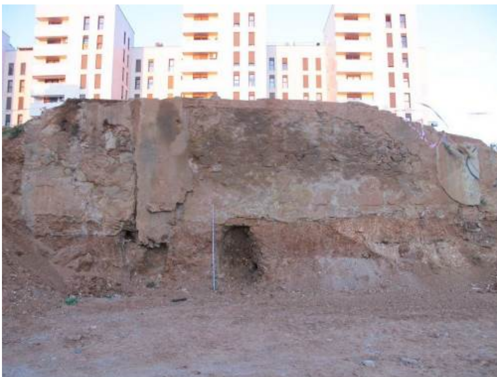
Foto 83: Mina. Tasques d'excavació mecànica
