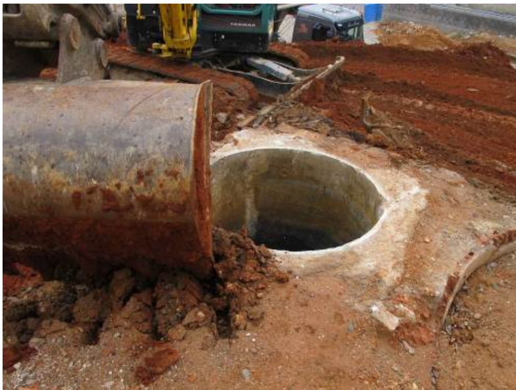
Foto 126: Tasques d'eliminació d'estructures amb supervisió. UE 18
