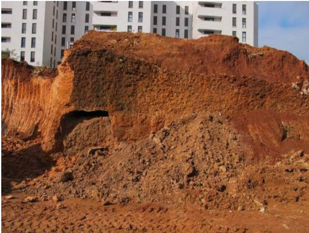
Foto 90: Tasques d'excavació al voltant de la mina
