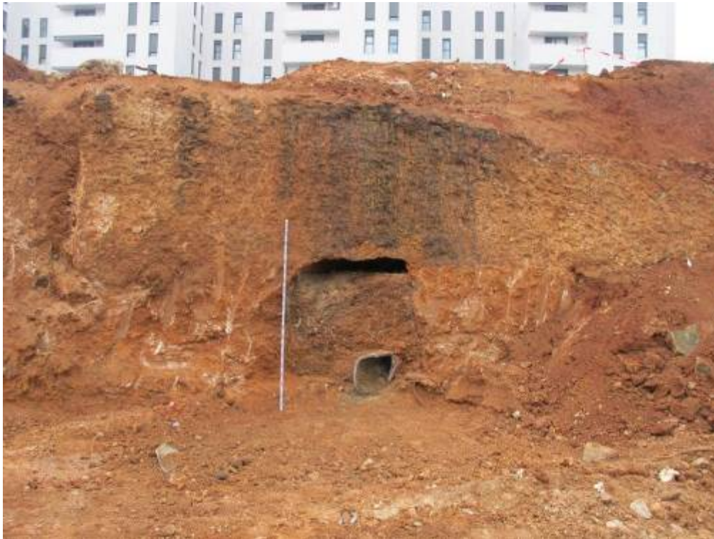
Foto 86: Estat de la mina després de la demolició del mur UE 11
