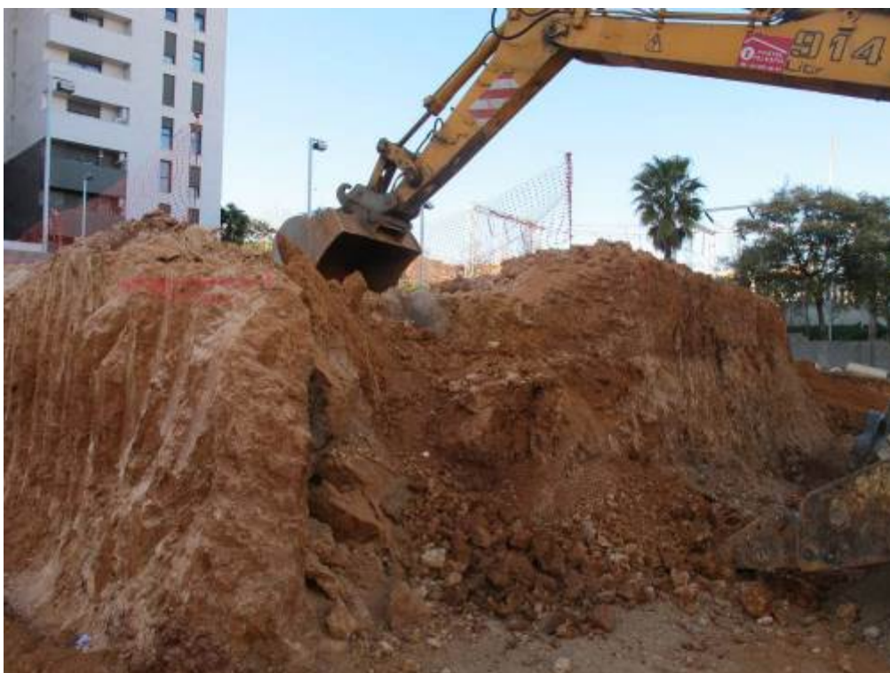
Foto 131: Tasques d'eliminació d'estructures amb supervisió. Mina UE 29
