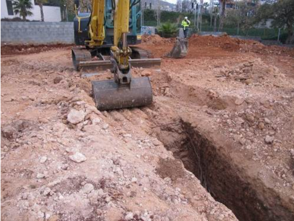
Foto 100: Mina. Excavació mecànica
