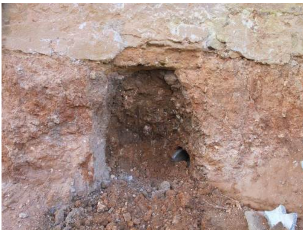
Foto 81: Mina. Tasques d'excavació mecànica
