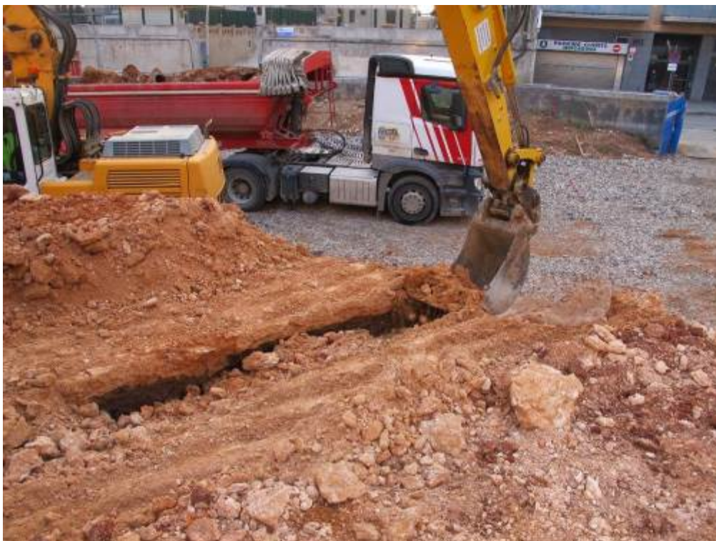
Foto 96: Mina. Excavació mecànica
