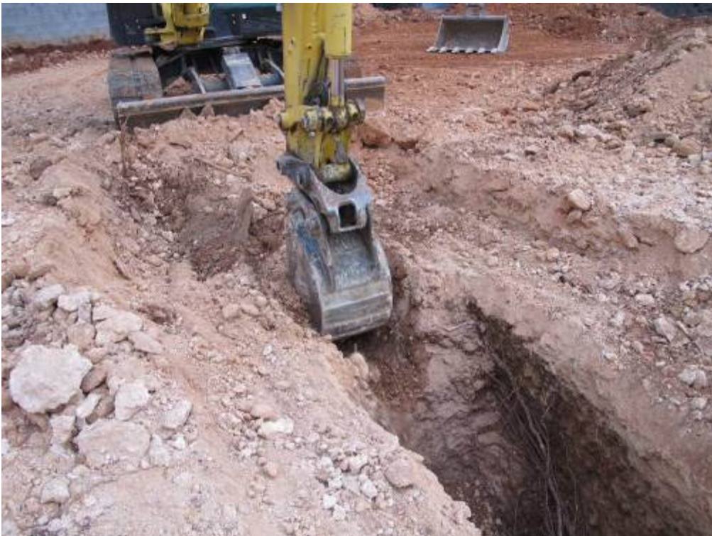
Foto 101: Mina. Excavació mecànica
