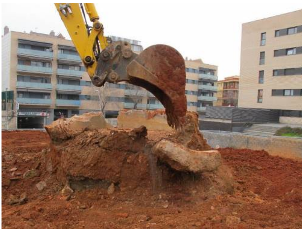
Foto 129: Tasques d'eliminació d'estructures amb supervisió. UE 17
