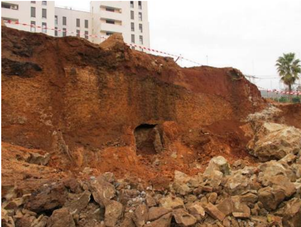
Foto 84: Estat de la mina després de la demolició del mur UE 11
