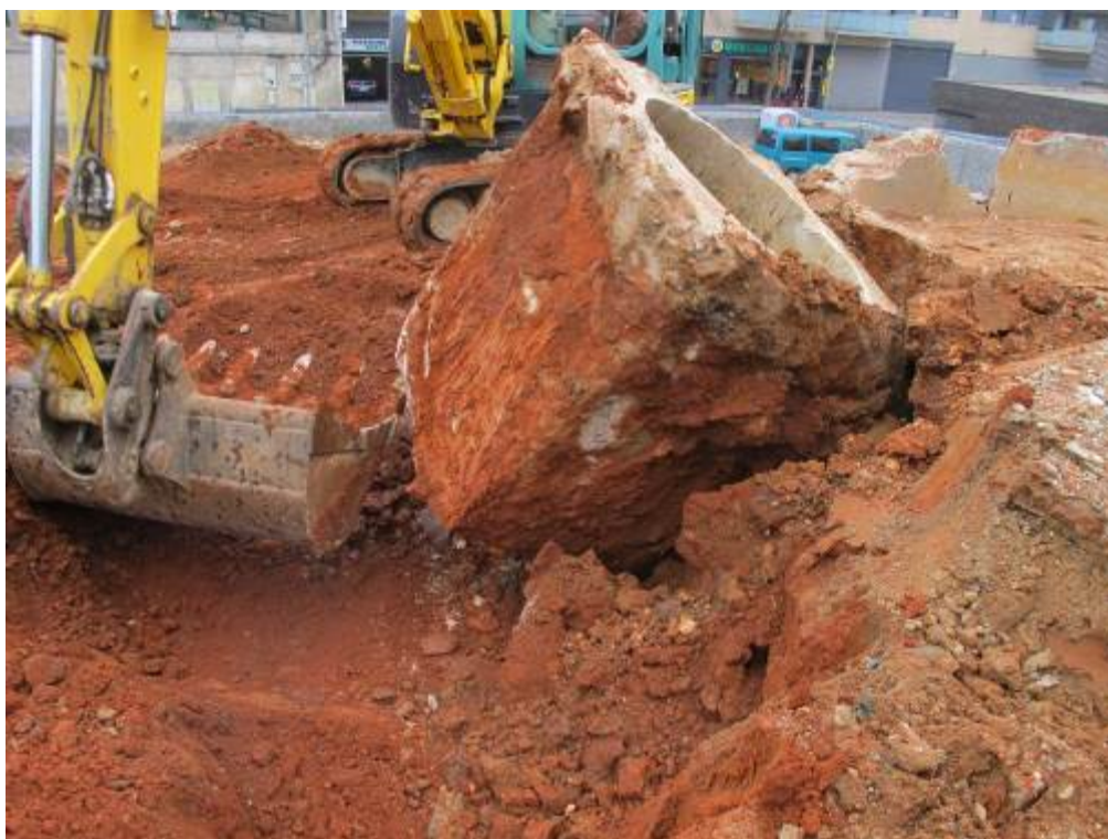
Foto 127: Tasques d'eliminació d'estructures amb supervisió. UE 18
