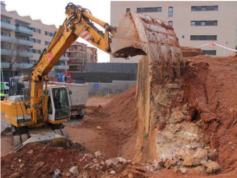
Foto 117: Tasques d'eliminació d'estructures amb supervisió. UE 11
