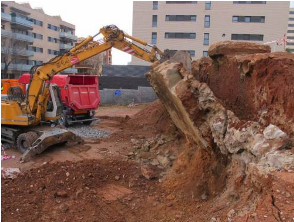
Foto 118: Tasques d'eliminació d'estructures amb supervisió. UE 11
