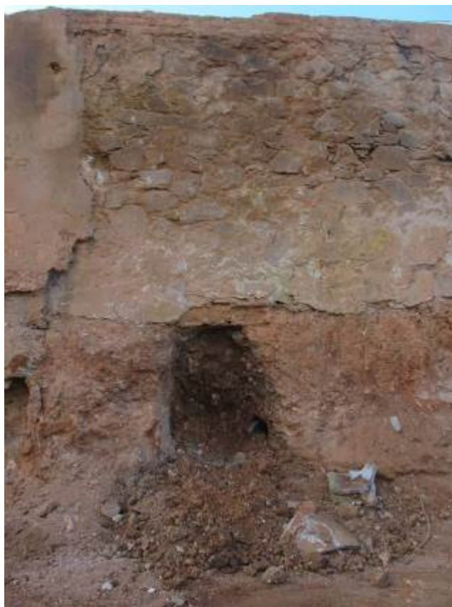
Foto 80: Mina. Tasques d'excavació mecànica
