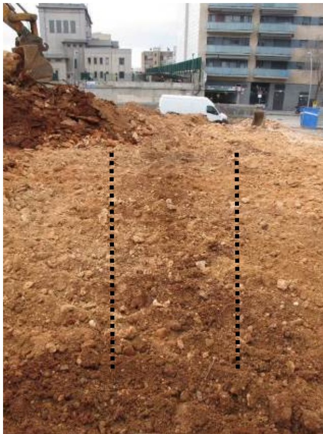
Foto 99: Mina després de l'extracció de la volta
