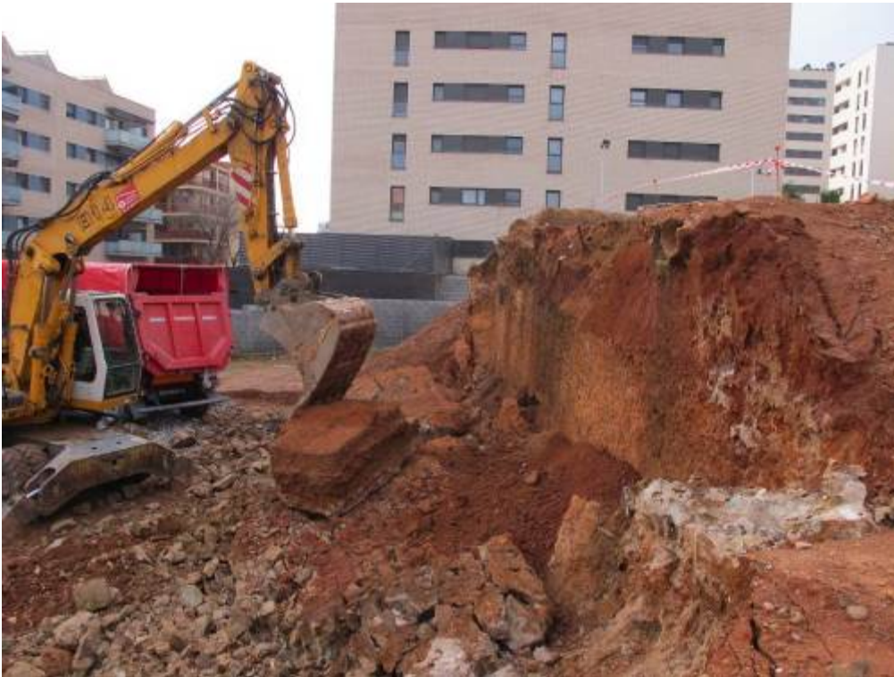
Foto 120: Tasques d'eliminació d'estructures amb supervisió. UE 16
