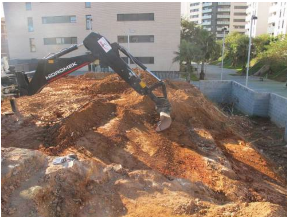
Foto 10: Meitat S. Tasques de delimitació d'estructures
