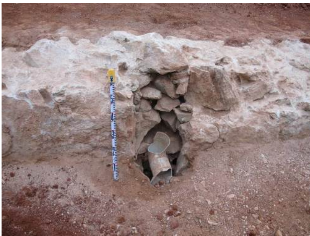
Foto 44: Mur UE 11, costat N. Detall d'un baixant de PVC
