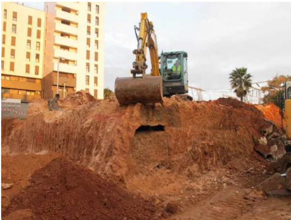
Foto 93: Mina. Tasques d'excavació per la part superior
