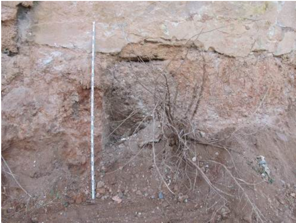
Foto 76: Inicial de la mina UE 29 per sota del mur UE 11
