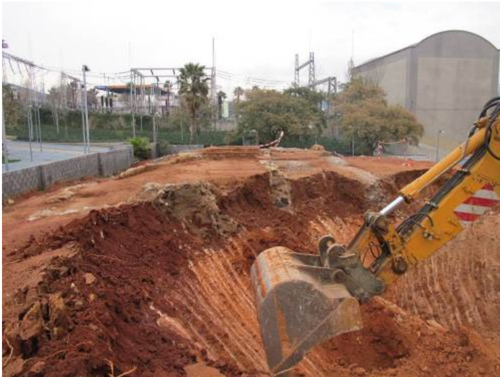
Foto 122: Tasques d'eliminació d'estructures amb supervisió
