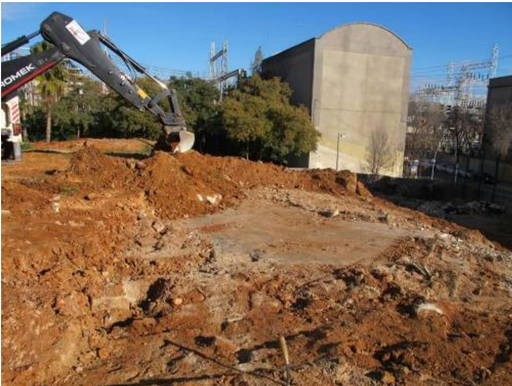
Foto 6: Restes del paviment UE 1
