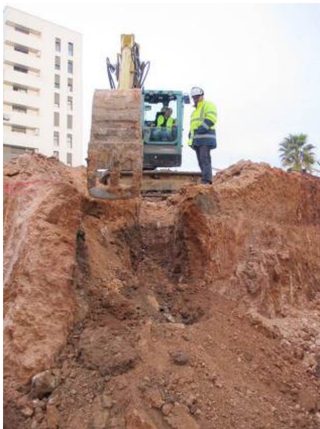
Foto 97: Mina. Tasques d'excavació per la part superior
