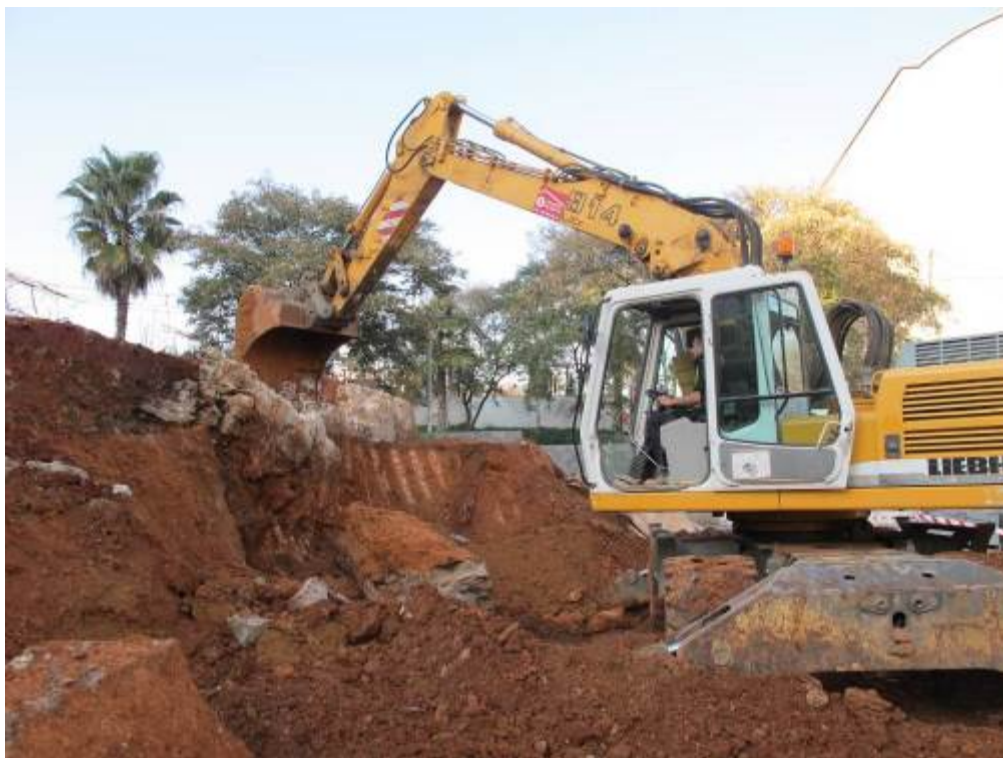
Foto 124: Tasques d'eliminació d'estructures amb supervisió. UE 11
