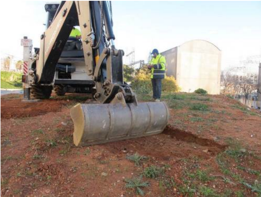
Foto 5: Inici dels treballs d'excavació
