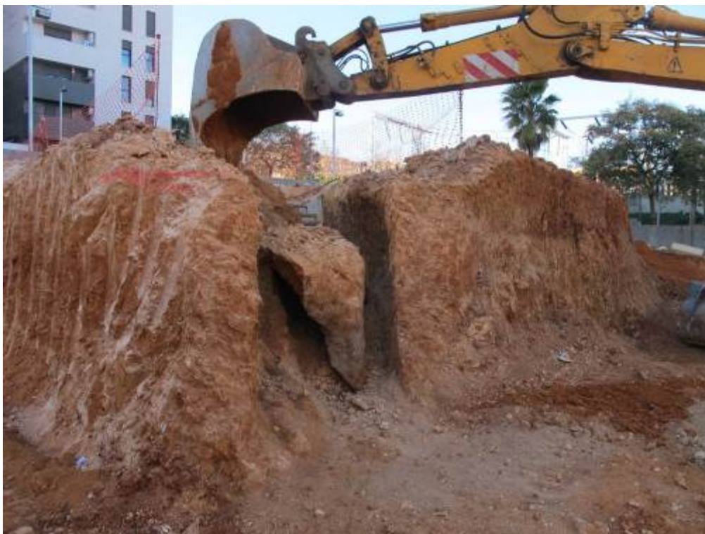
Foto 130: Tasques d'eliminació d'estructures amb supervisió. Mina UE 29
