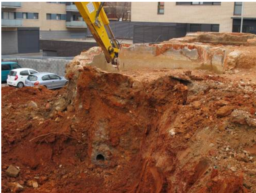
Foto 128: Tasques d'eliminació d'estructures amb supervisió. UE 17
