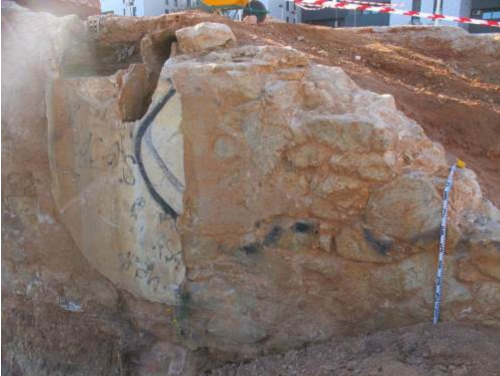
Foto 37: Alçat E del mur UE 11, costat S, amb afectació per rampa
