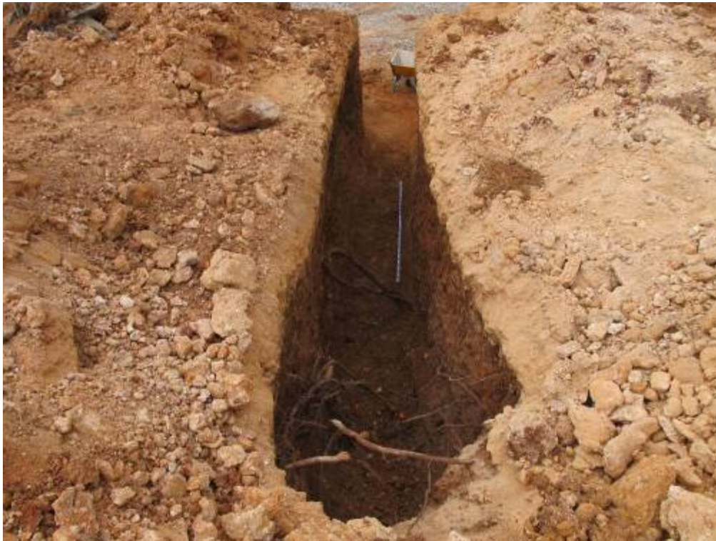
Foto 98: Mina. Excavació mecànica
