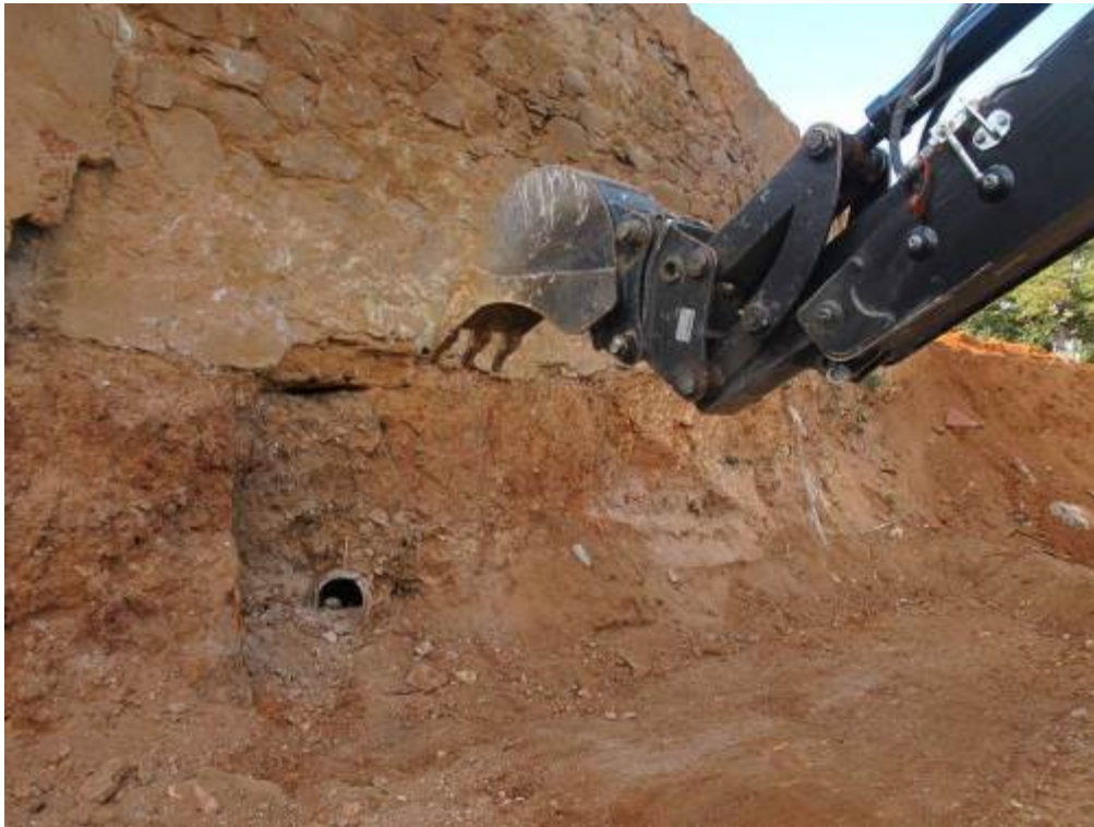
Foto 78: Mina. Tasques d'excavació mecànica
