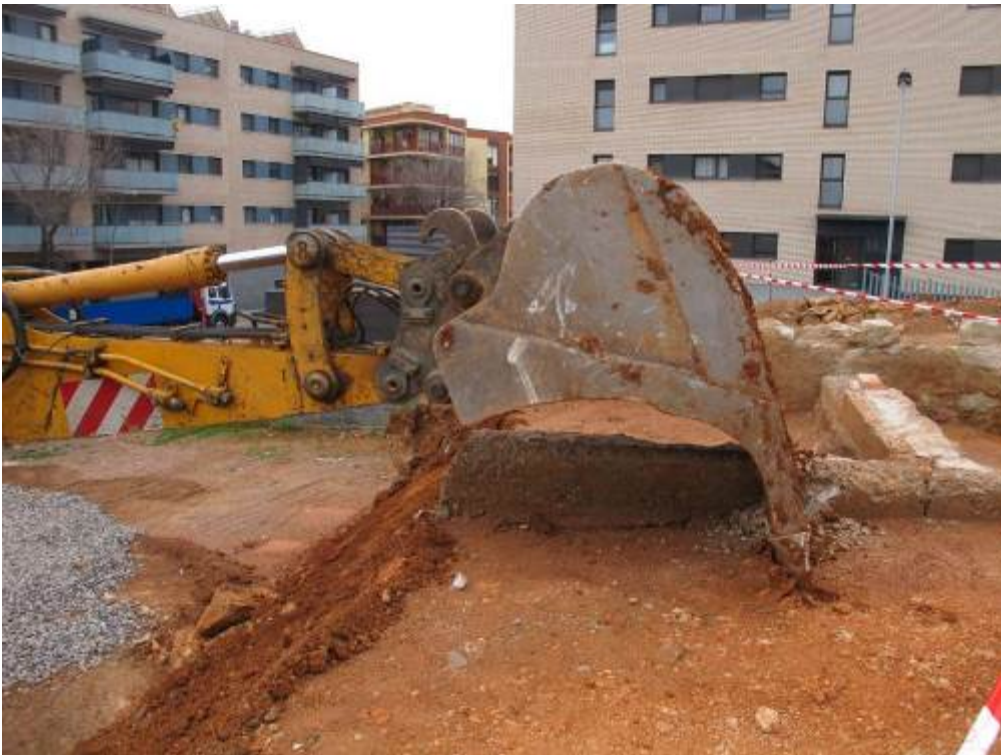
Foto 121: Tasques d'eliminació d'estructures amb supervisió. UE 13
